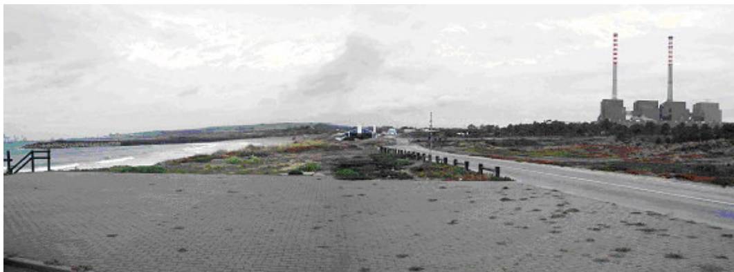
Central Termoeléctrica de Sines, junto à praia de S o Torpes
